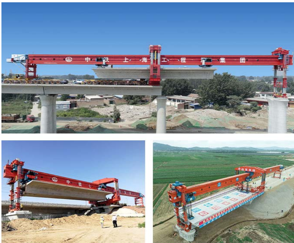
Рис. 1. Мостовой консольно-шлюзовой кран с одной направляющей балкой
